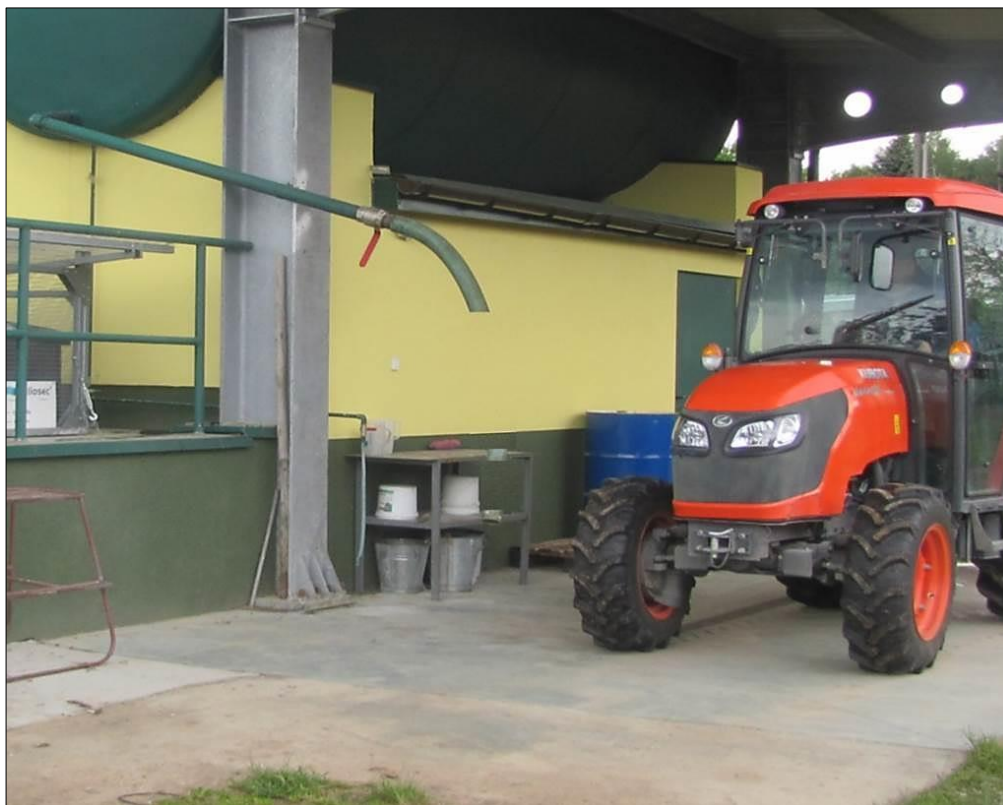
Rys. 5. Miejsce do odmierzania i wstępnego rozwadniania środków ochrony roślin z blatem i ujęciem wody na stanowisku do napełniania i mycia opryskiwacza
