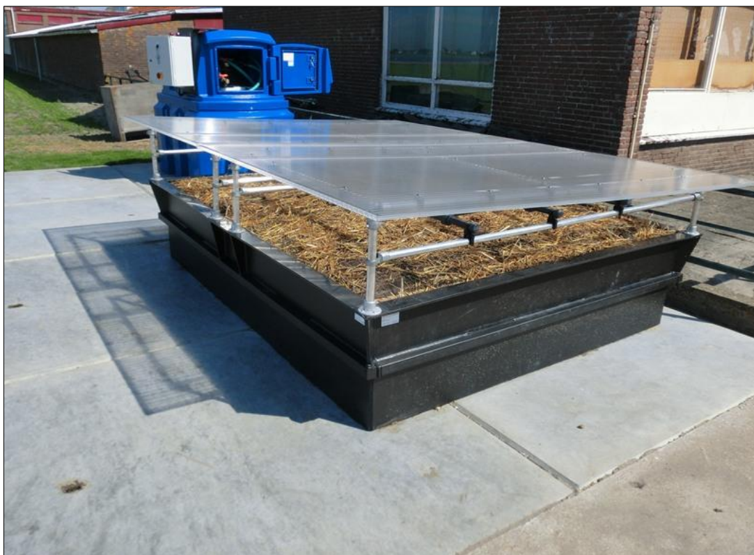
Rys. 29. Stanowisko bioremediacyjne PHYTOBAC w basenie z tworzywa sztucznego
