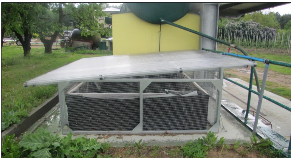
Rys. 54. HELIOSEC – stanowisko dehydracyjne o pojemności zbiornika 2500 l
