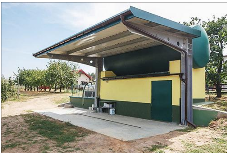
Rys. 3. Zadaszone stanowisko do napełniania i mycia opryskiwacza
