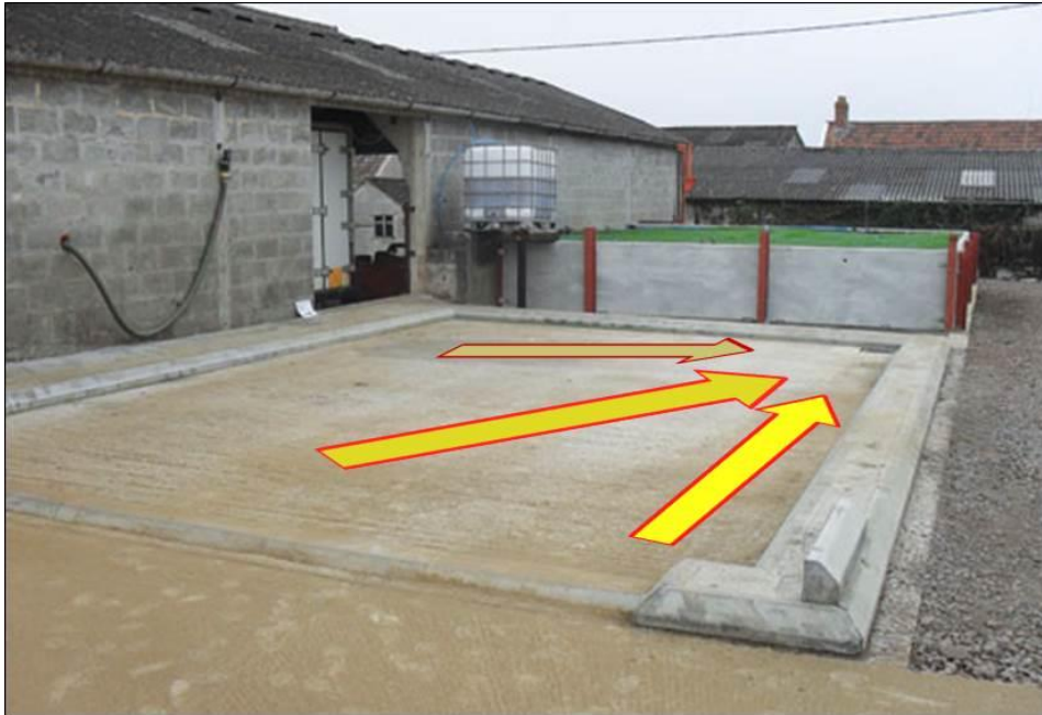
Rys. 2. Obandowana płyta betonowa ze spływem wody do kratki ściekowej
