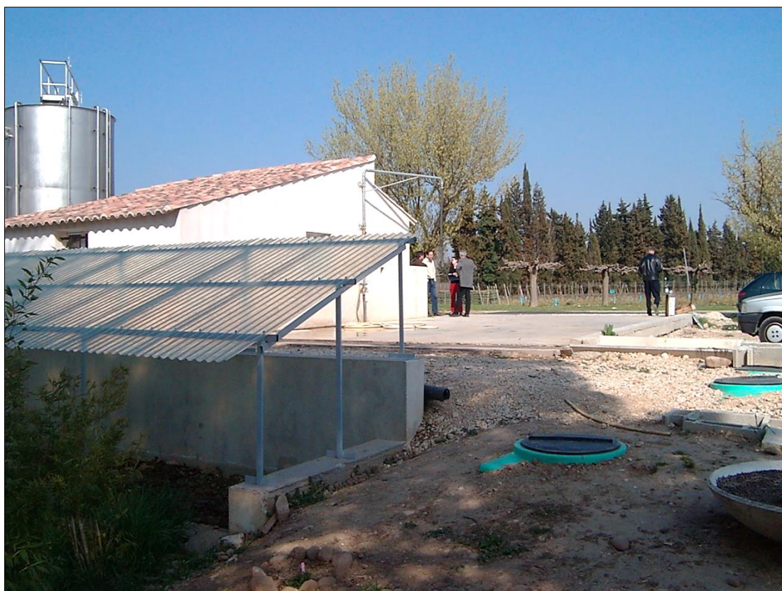
Rys. 37. Stanowisko bioremediacyjne PHYTOBAC z grawitacyjnym sływem wody ze stanowiska do napełniania i mycia opryskiwacza
