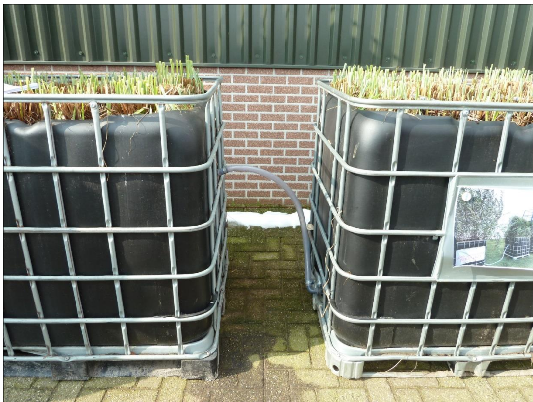
Rys. 44. Odbiór odcieków z bocznych kontenerów stanowiska BIOFILTER
